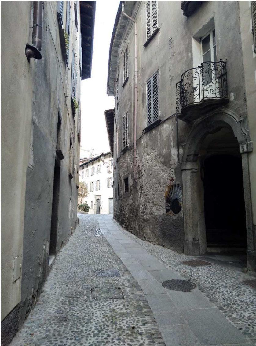
Nuova pavimentazione della "via dei Palazzi" riaperta al transito nel mese di luglio 2023
